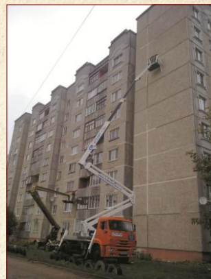
Утепление фасада жилого дома
