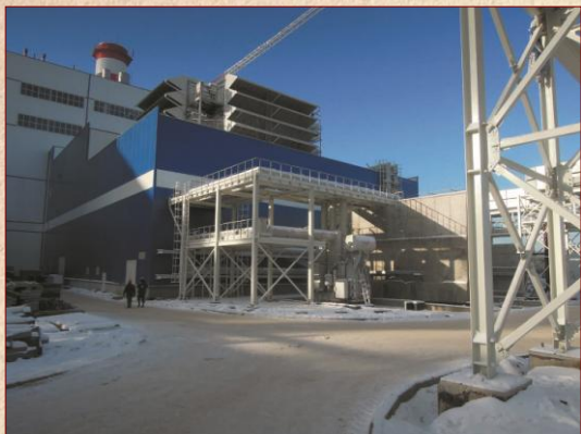
Подготовка к пуску нового энергоблока на ТЭЦ - 2
